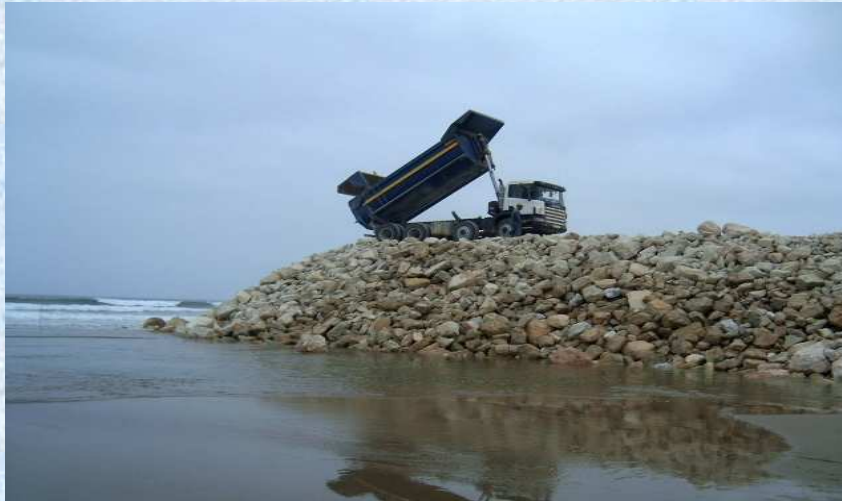
Digue provisoire de protection
