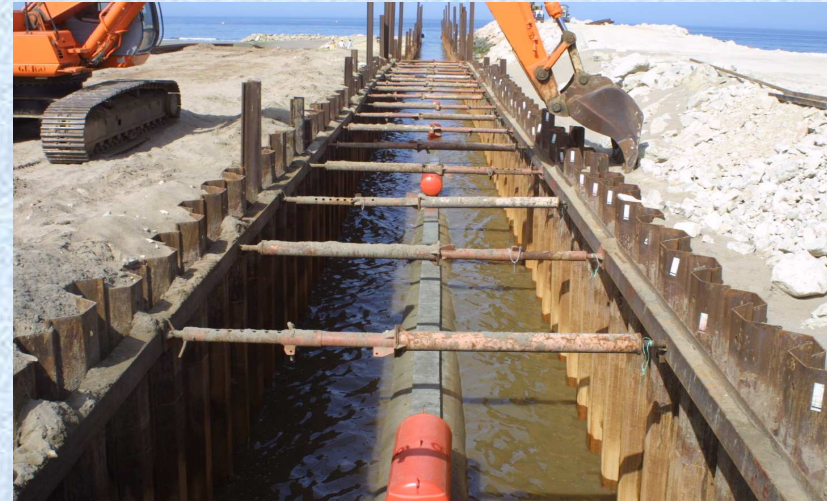
Rideau de palplanches - pose d'émissaire
